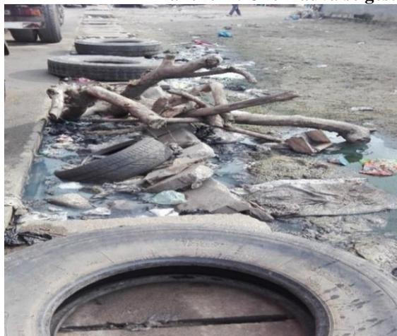
Photo 3 : Un caniveau d'eau pluviale obstrué par les déchets de toutes sortes
