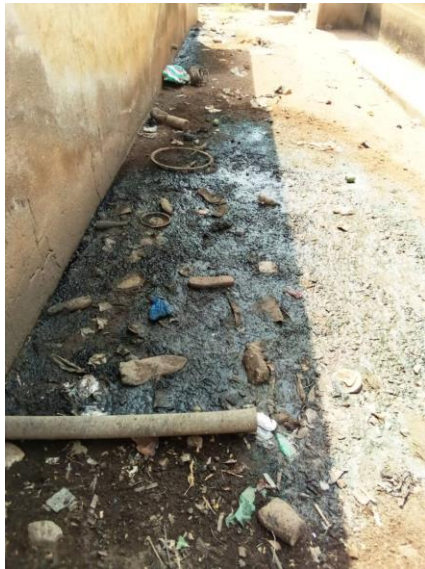
Photo 3: Présence d'eau usée derrière une maison au quartier Kamagaha. (Prise de vue: Bakary Nambahigué Mathieu, 2021)
