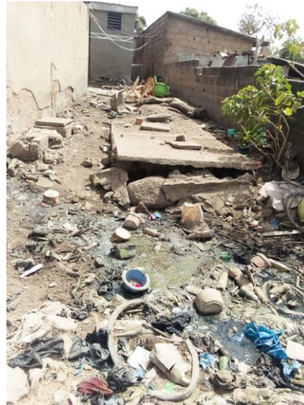
Photo 4: Une fosse septique ouverte laissant les eaux vannes coulées dans une concession au quartier Djimisso. (Prise de vue: Bakary Nambahigué Mathieu, 2021)
